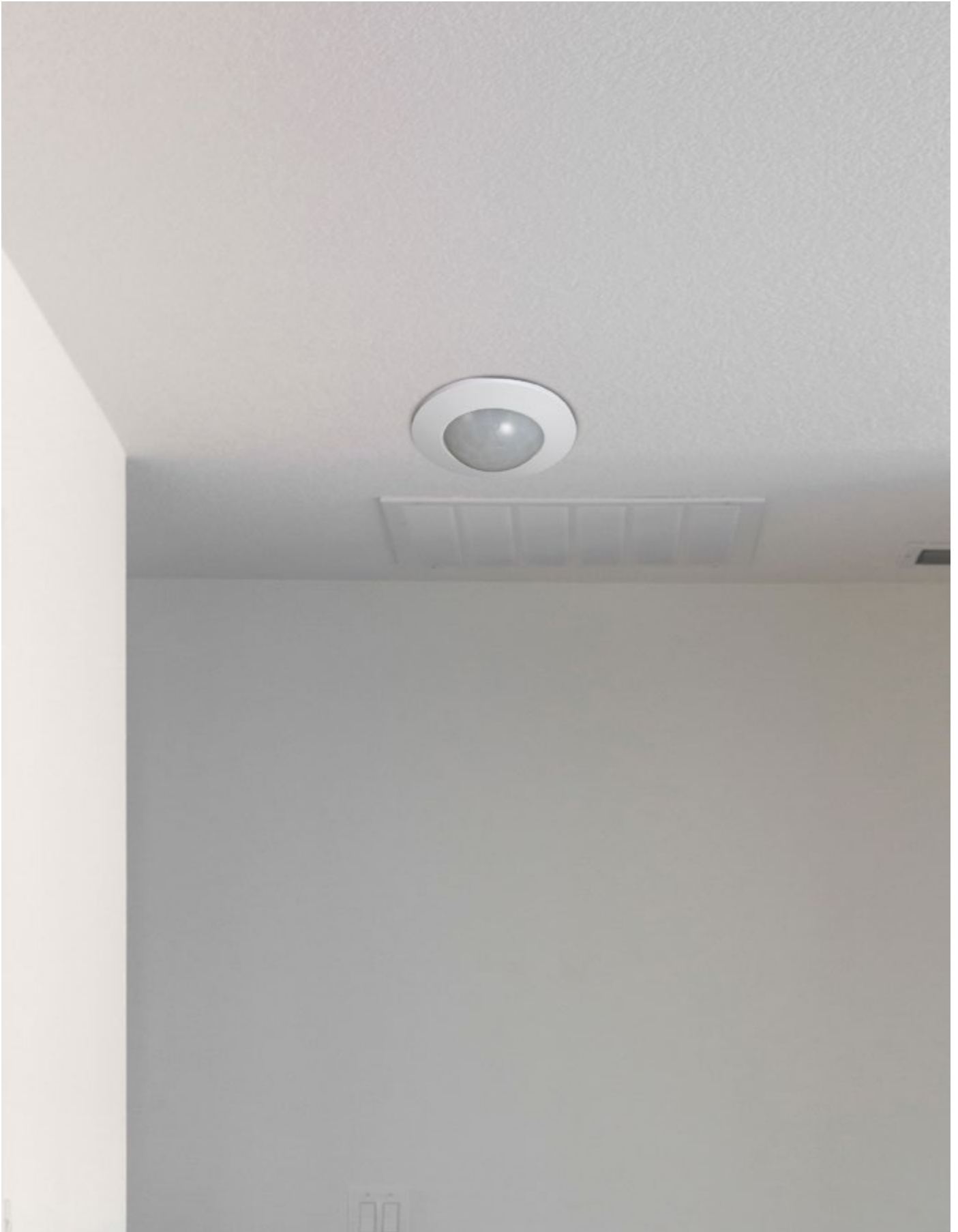
Detalle de instalación de Move 1 .
