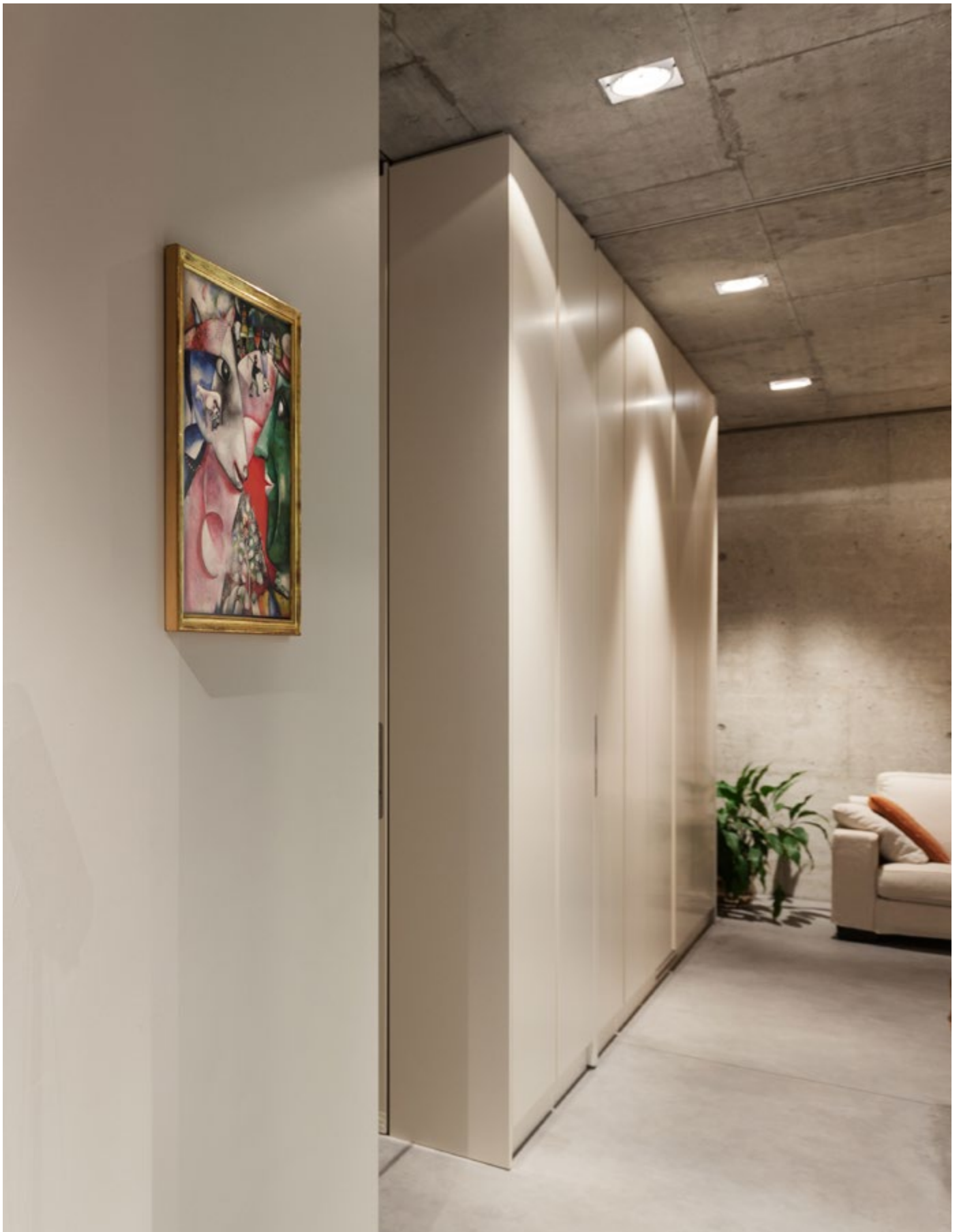
El efecto de luz emitido por los spotlights orientados a la pared en el interior de una vivienda.
